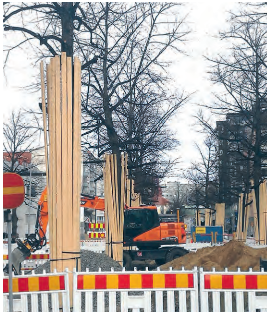
Vanhan katupuuston suojaus työmaalla pidentää puiden elinkaarta ja säilyttää niiden hiilivarastoja.
